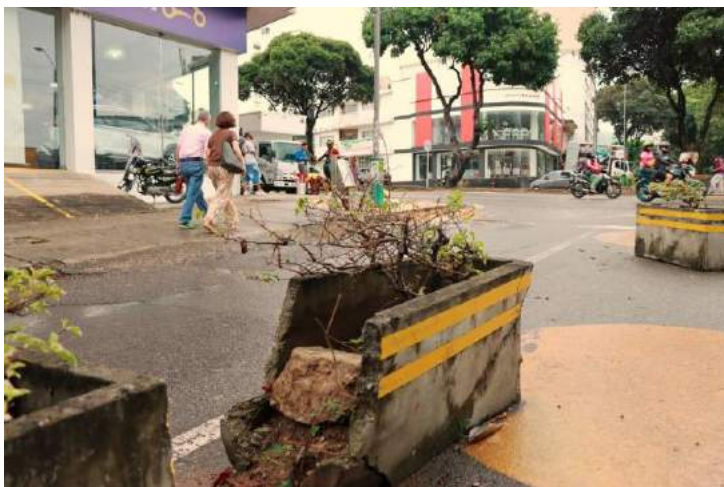
Elementos de urbanismo táctico en un estado lamentable por la falta de seguimiento y mantenimiento. Bucaramanga, Colombia.
