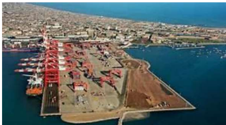
Vista aérea del sitio donde se construye el Megapuerto de Chancay, en Perú (Foto: Divulgación)
